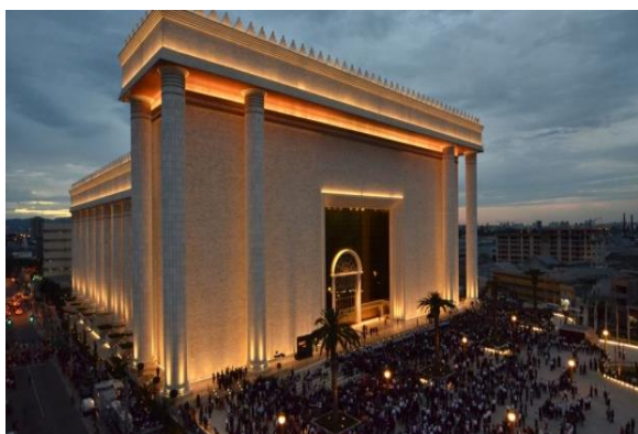
Fig. 4 Fachada do TdS em São Paulo. 75
